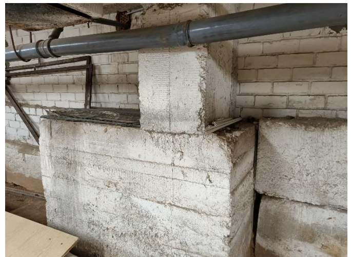
8 pav. Vienoje iš patalpų užfiksuoti atviri kolonų pamatai, kurie įrengti iš skirtingų matmenų padų.
