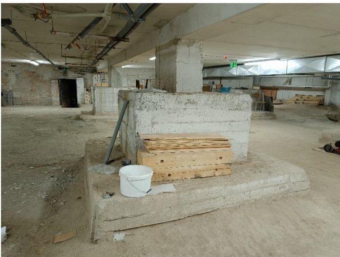
7 pav. Vienoje iš patalpų užfiksuoti atviri kolonų pamatai, kurie įrengti iš skirtingų matmenų padų.
