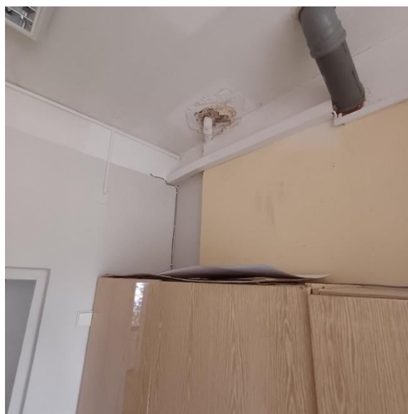
20 pav. Vamzdžių ir konstrukcijų sankirtoje užfiksuoti nesandarumo požymiai.
