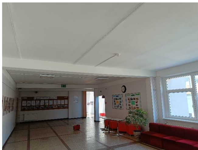
18 pav. Rygelių ir perdangos plokščių bendras vaizdas. Konstrukcijų būklė gera.
